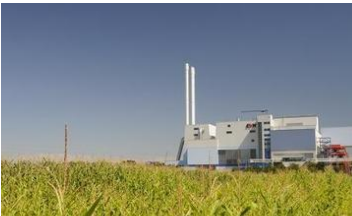
Slika 6. Energana za spaljivanje plastike
