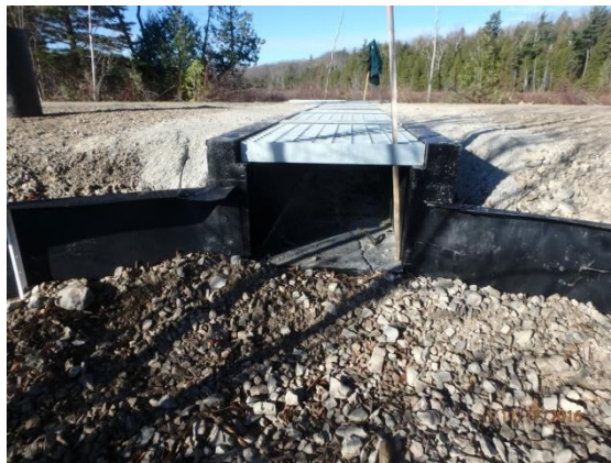
Slika 5.: Privremena ograda za usmjeravanje i tunel za vodozemce ( https://animexfencing.com/ )
