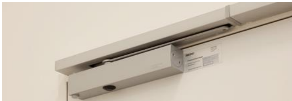
Slika 9. Uređaj za automatsko zatvaranje vrata [21]
