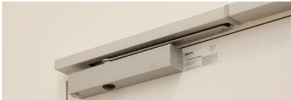
Slika 9. Uređaj za automatsko zatvaranje vrata [21]
