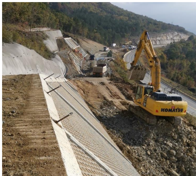
Slika 26.e Iskop bagerom
