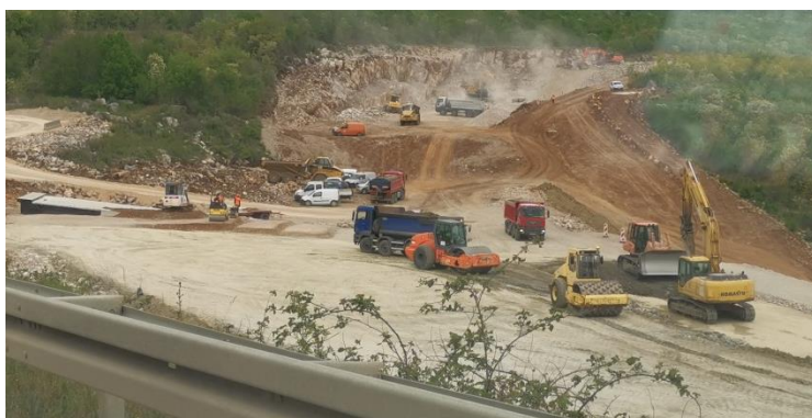
Slika 26.b Strojevi na izgradnji ceste
