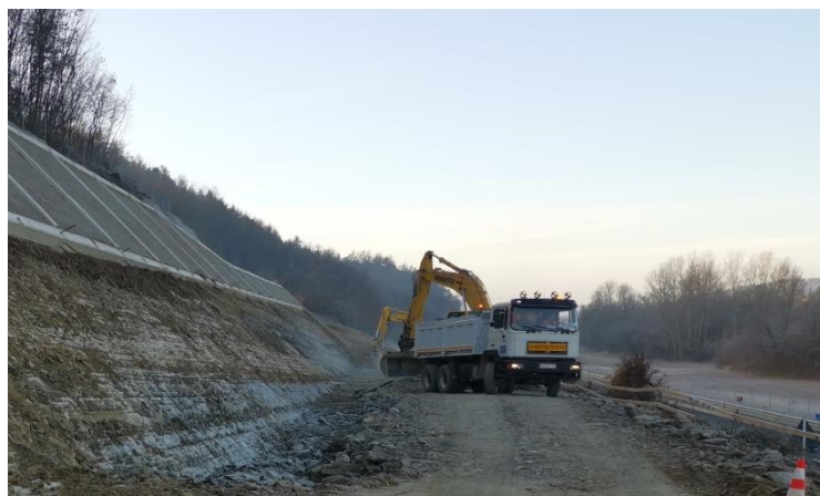
Slika 26.d Utovar kamiona kipera bagerom
