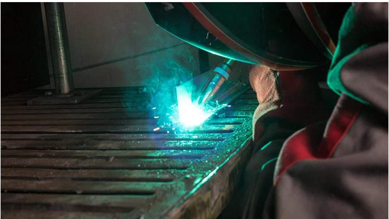
Slika 12. Zavarivanje MAG postupkom [8]
