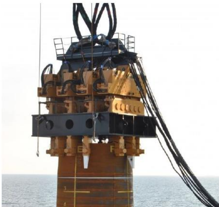
Slika 23. Četiri vibratora sastavljena kod izgradnje podmorske vjetroelektrane [23]
