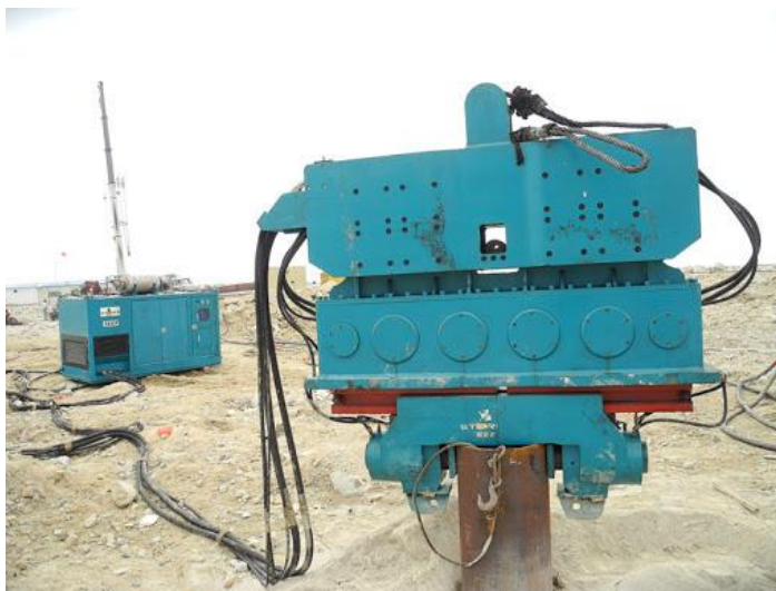
Slika 18. Primjena vibracijskog zabijača u praksi [27]
