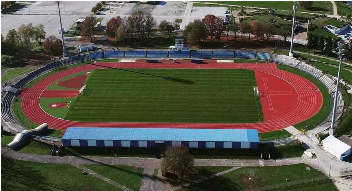
Fotografija 3. Stadion „Branko Čavlović Čavlek“ u Karlovcu
