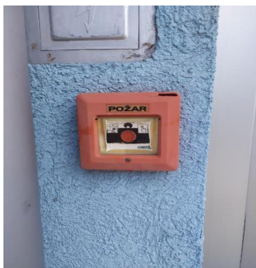
Slika 15. Ručni javljač požara. (Izvor: autor)
