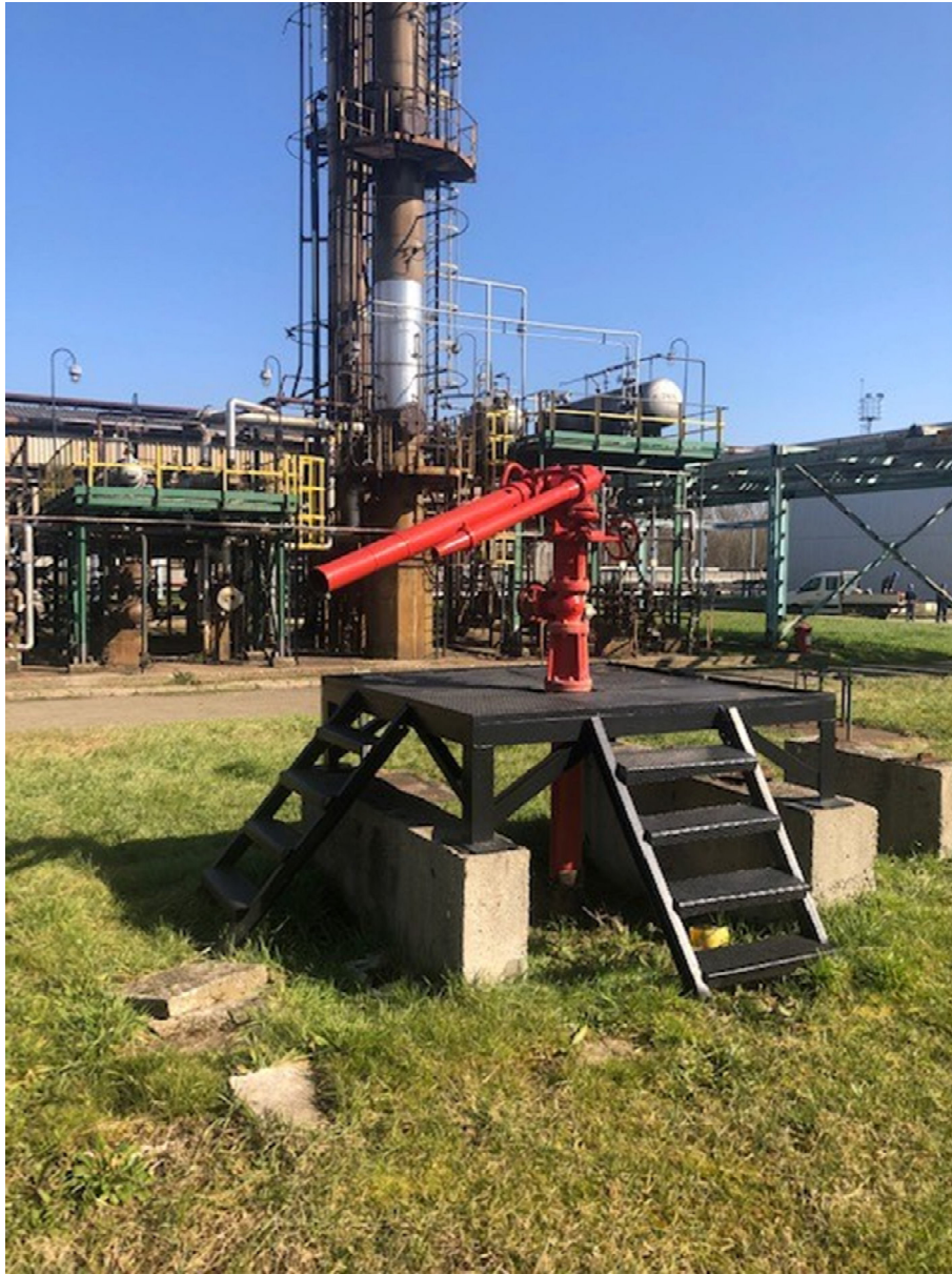
Slika 13. Stabilni bacač voda/pjena na KP-5 [7]
