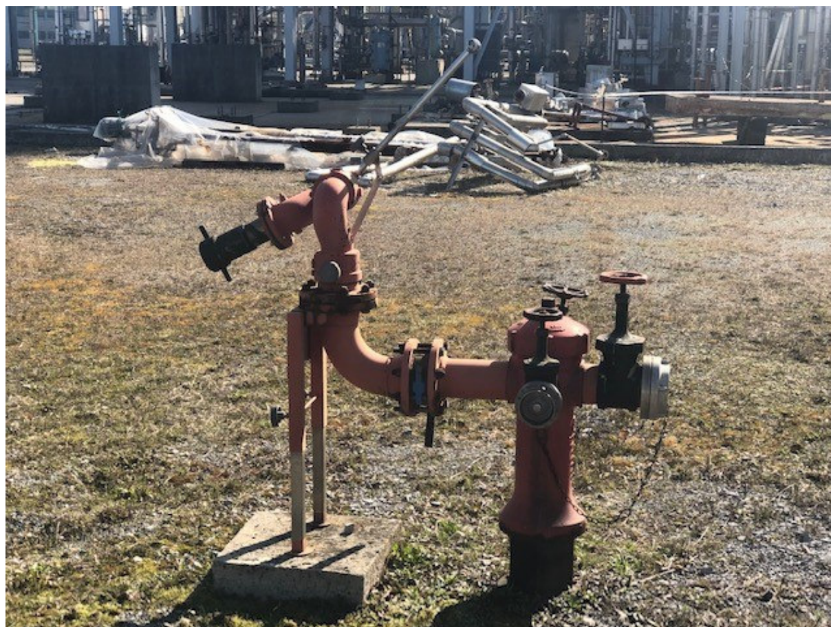
Slika 12. Stabilni bacač vode na SRU [7]
