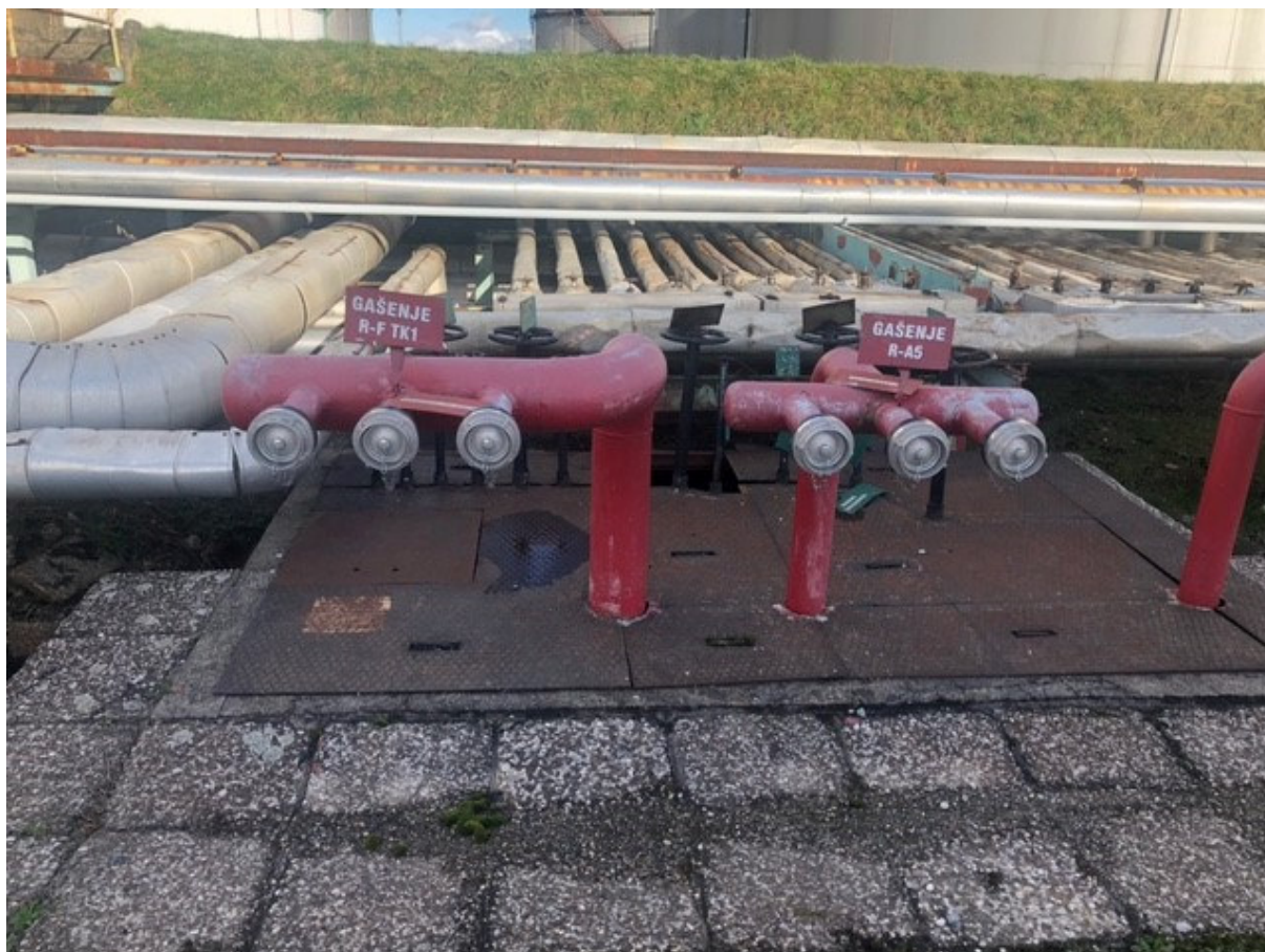
Slika 6. Polustabilni sustav za gašenje spremnika [7]
