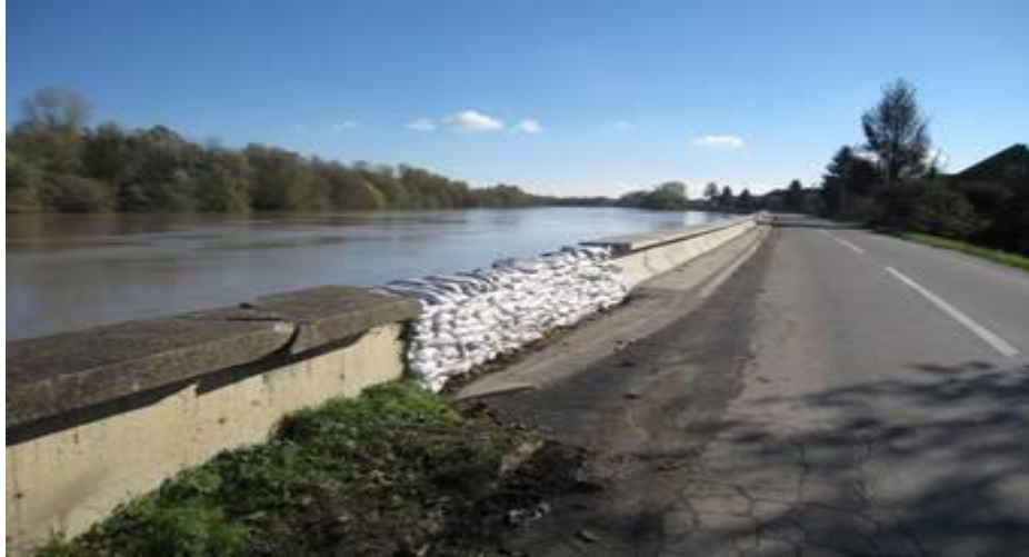
Slika 5: obrambeni zid od rijeke Save u Lonjskom polju
