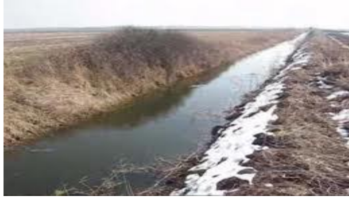
Slika 20: Kanal za odvođenje vode
