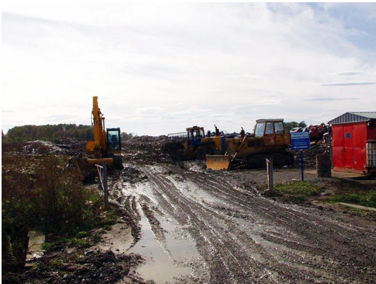
Slika 18: sanacija odlagališta komunalnog otpada u Kutini
