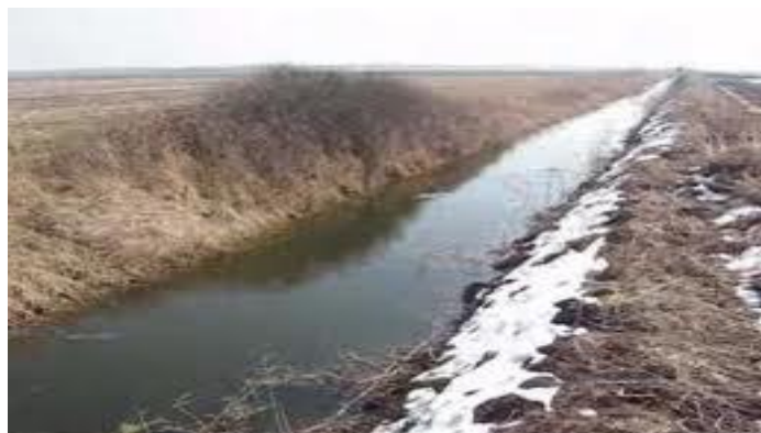
Slika 20: Kanal za odvođenje vode
