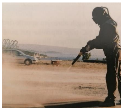
Slika 20. Pravilno zaštićen radnik prilikom suhog pjeskarenja [1].
