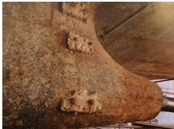
Slika 6. Opća korozija podvodnog dijela brodskog trupa [1]
