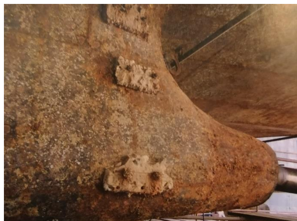
Slika 6. Opća korozija podvodnog dijela brodskog trupa [1]
