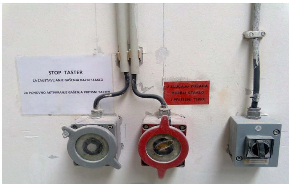
Slika 38. Uređaj za ručno aktiviranje/prekidanje gašenja sa ugljičnim dioksidom
