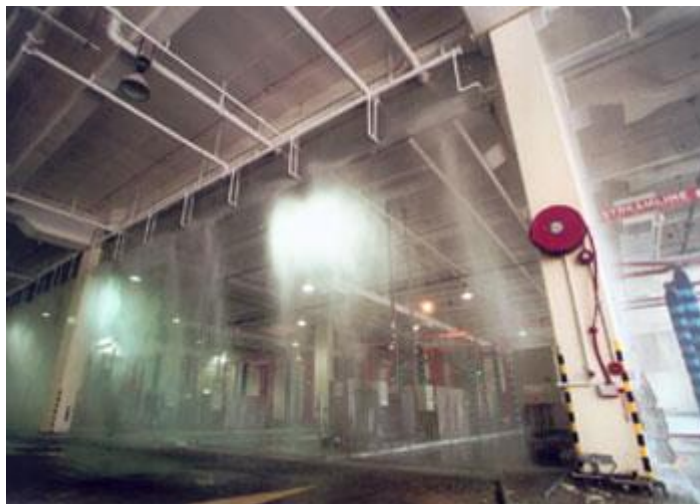
Slika 4. Drencher sustav
