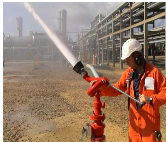
Slika 16. Ručno upravljani bacač vode/pjene
