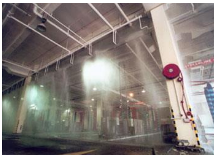
Slika 4. Drencher sustav
