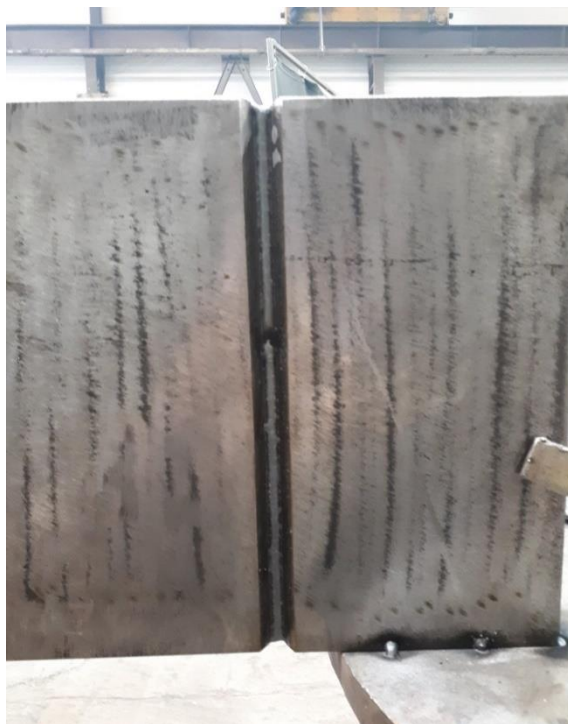
Slika 16. Kompletно zavaren korijen zavora
