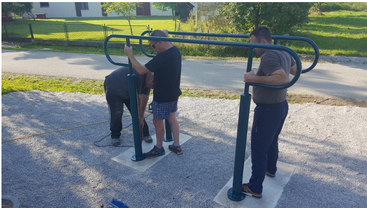
Slika 9. Volonteri postavljaju fitness sprave u sklopu projekta „Fitness pod vedrim nebom“
