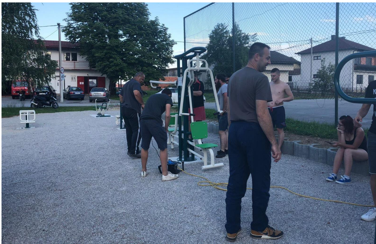
Slika 15. Volonteri postavljaju fitness sprave u sklopu projekta „Fitness pod vedrim nebom“
