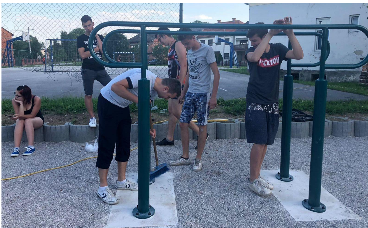
Slika 16. Volonteri postavljaju fitness sprave u sklopu projekta „Fitness pod vedrim nebom“
