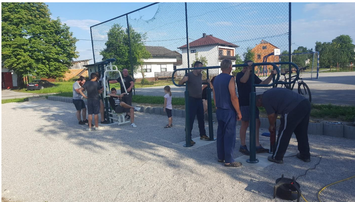
Slika 10. Volonteri postavljaju fitness sprave u sklopu projekta „Fitness pod vedrim nebom“
