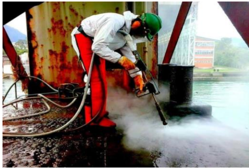
Slika 20: Čišćenje površine mlazom vode [26]
