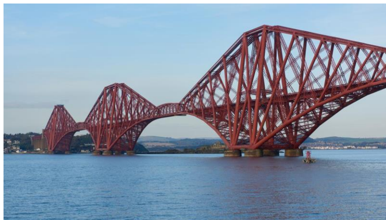
Slika 1. Čelični most Forth Bridge [3]
