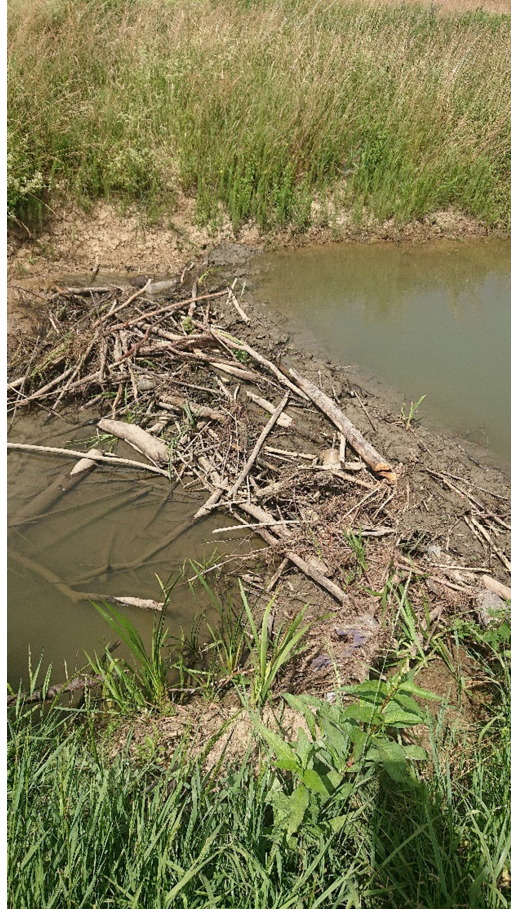
Slika 9: Brana na potoku Cukovec
