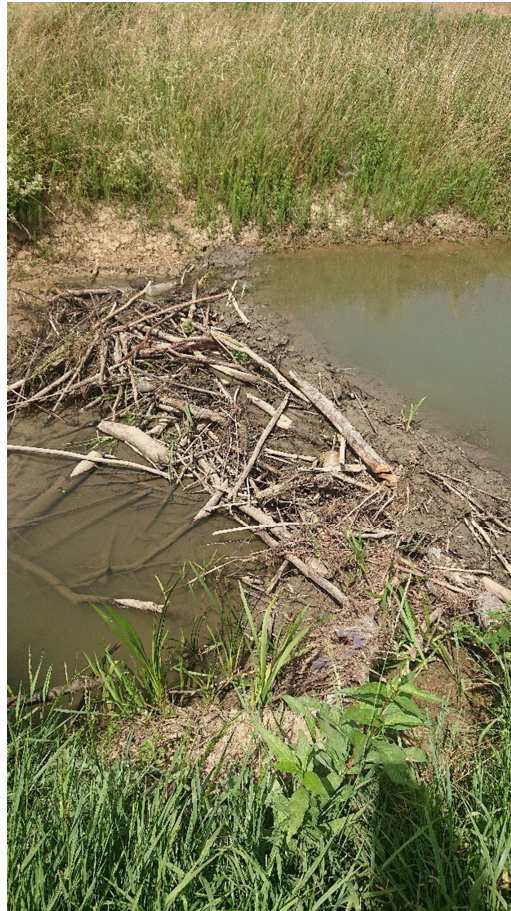
Slika 9: Brana na potoku Cukovec
