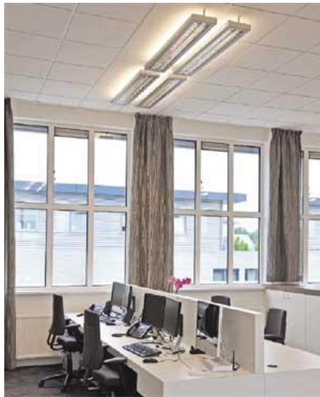
Slika 11. Neizravna rasvjeta osvjetljava stropove.
