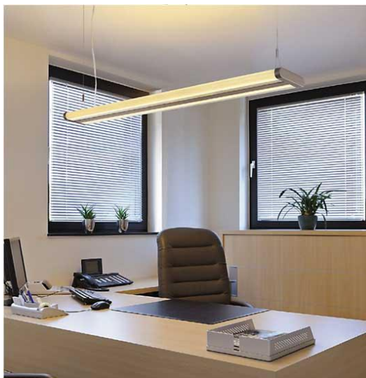
Slika 10. Rasvjeta ureda s promjenjivim radnim jedinicama.
