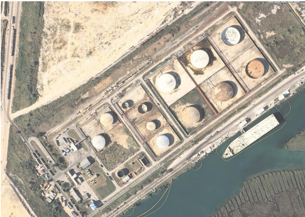
Slika 5. Spremnici – NTF d.o.o. Ploče, Skladište za tekuće terete u Luci Ploče.
