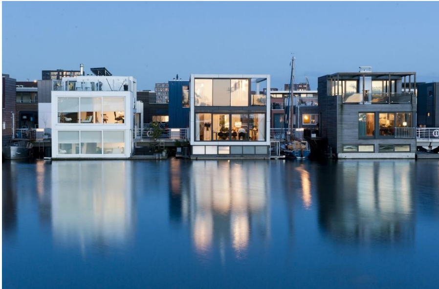
Slika 9. Apartmani na rijeci
