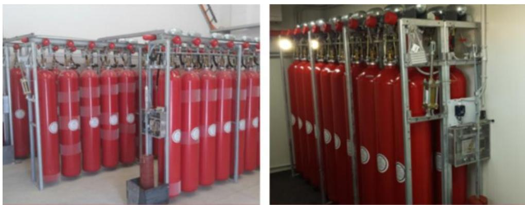
Slika 12. Visokotlačni sustav za gašenje požara ugljičnim dioksidom [7]
