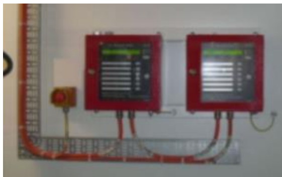
Slika 18. Uređaj za vremensku odgodu ispuštanja ugljičnog dioksida [7]
