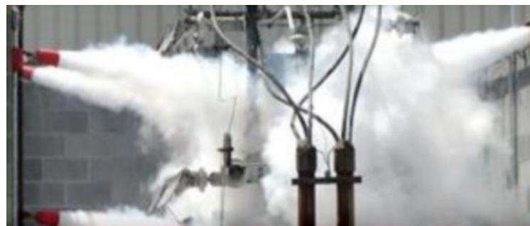
Slika 15. Djelomična zaštita ugljičnim dioksidom [4]
