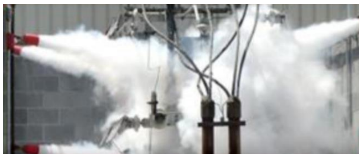
Slika 15. Djelomična zaštita ugljičnim dioksidom [4]
