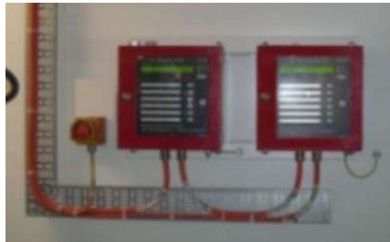
Slika 18. Uređaj za vremensku odgodu ispuštanja ugljičnog dioksida [7]
