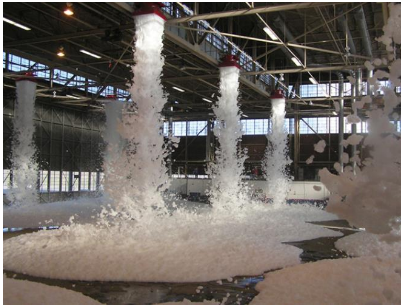
Slika 11. Stabilni sustav za gašenje – pjenom [7]
