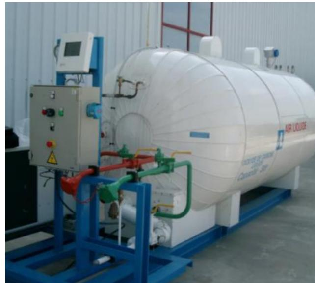
Slika 13. Spremnik niskotlačnog sustava za gašenje požara ugljičnim dioksidom
