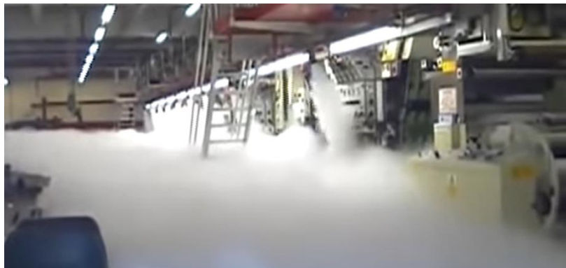
Slika 14. Potpuna zaštita ugljičnim dioksidom [4]
