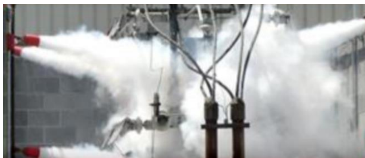
Slika 15. Djelomična zaštita ugljičnim dioksidom [4]
