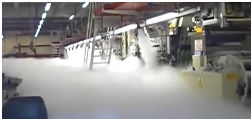
Slika 14. Potpuna zaštita ugljičnim dioksidom [4]
