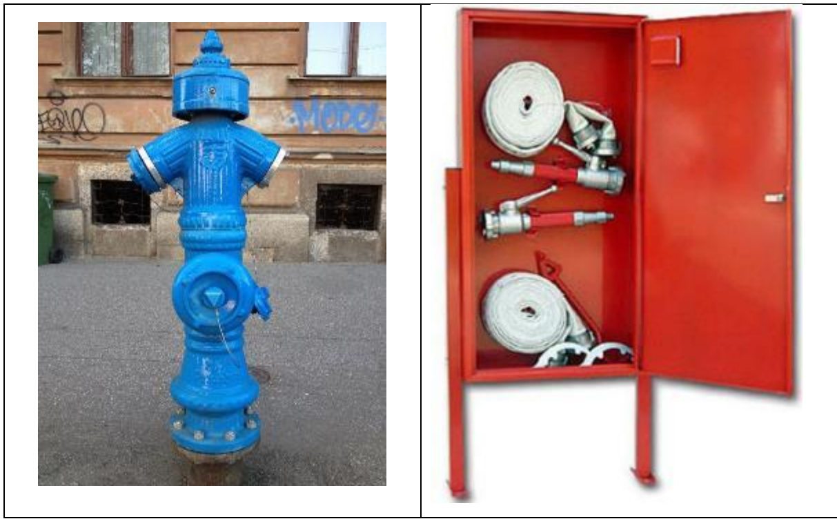
Slika 17. Primjer vanjskog hidranta, zajedno s ormarićem u kojemu se nalazi oprema. [22]
