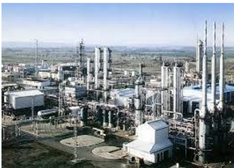
Slika 8: Centralna plinska stanica Molve
