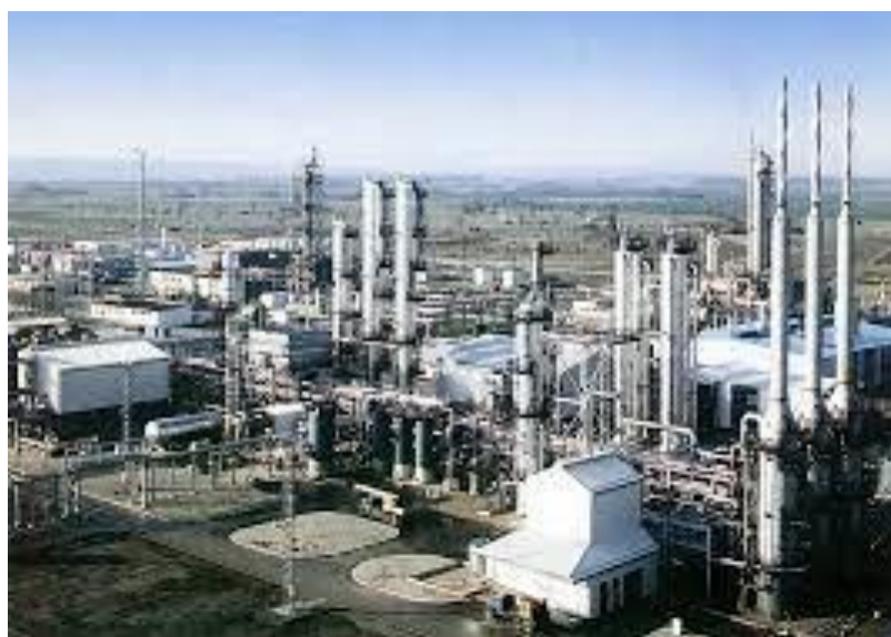
Slika 8: Centralna plinska stanica Molve
