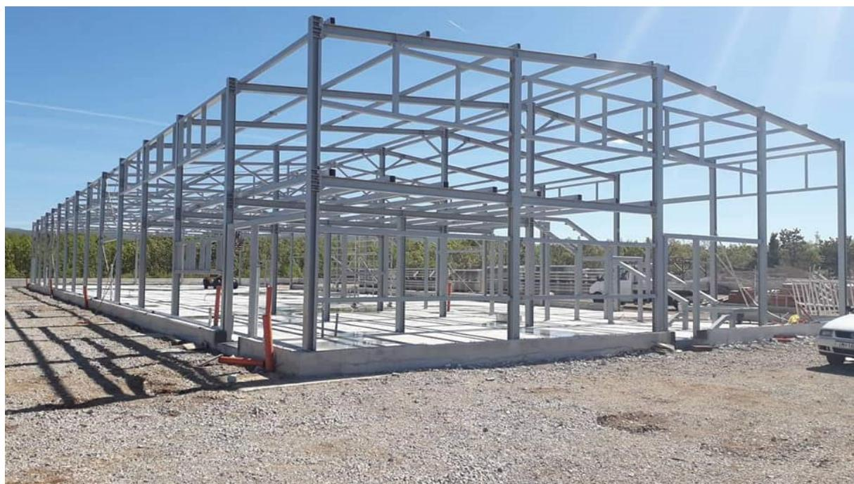
Slika 25. Prikaz montiranih čeličnih profila
