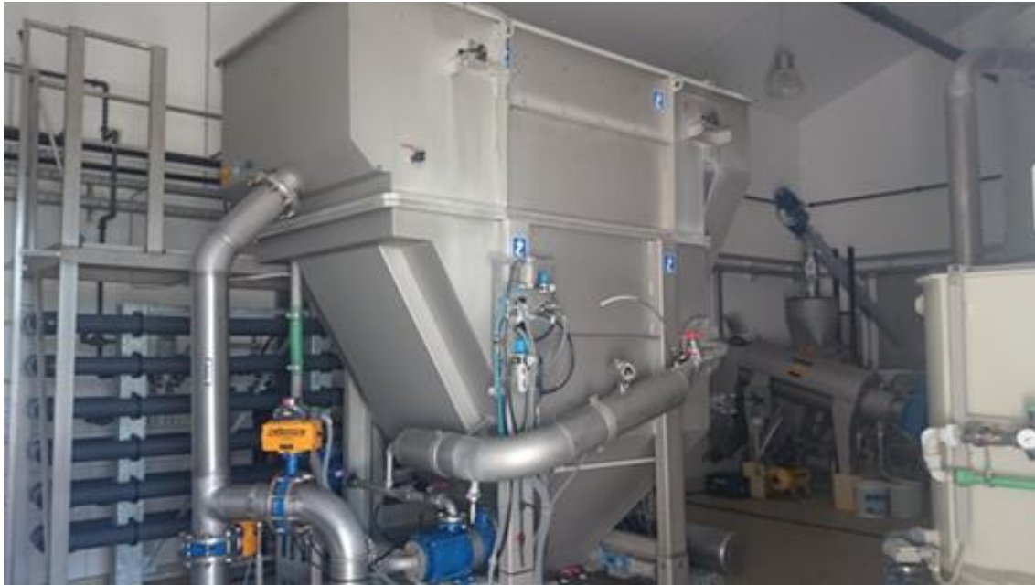
Slika 9: Tehnološka linija DAF [18]
