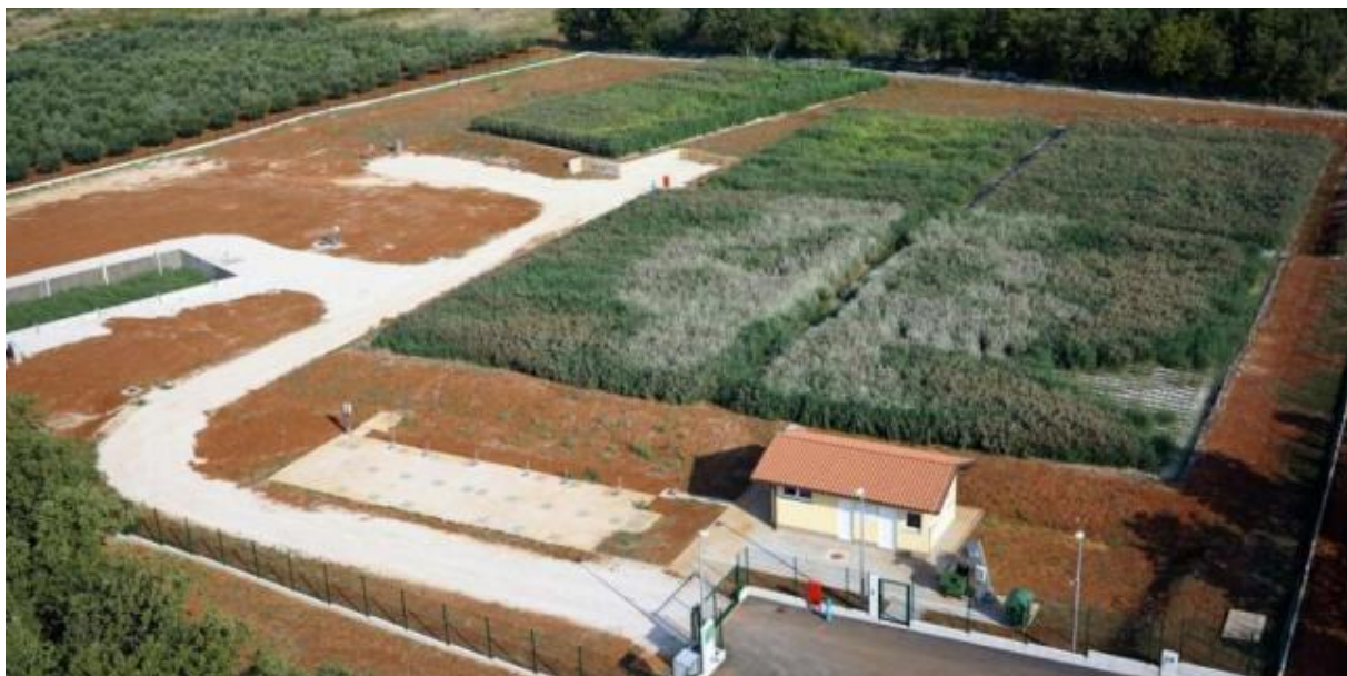
Slika 1 - Najveći biljni pročišćivač otpadnih voda u Hrvatskoj Kaštelir-Labinci (Parentium.com, 2016)
