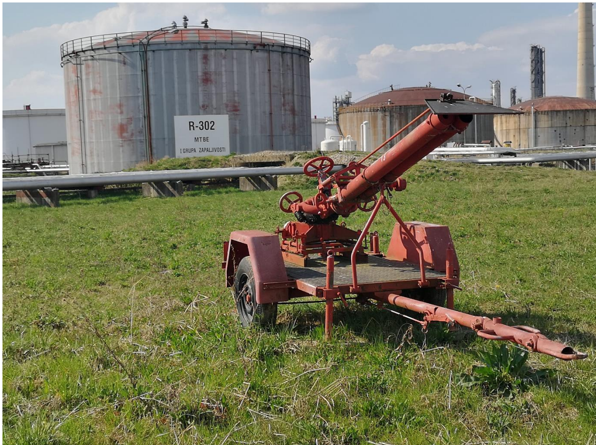
Slika 3. Rezervoar s ravnim krovom i mobilni bacač vode / pjene [3]
