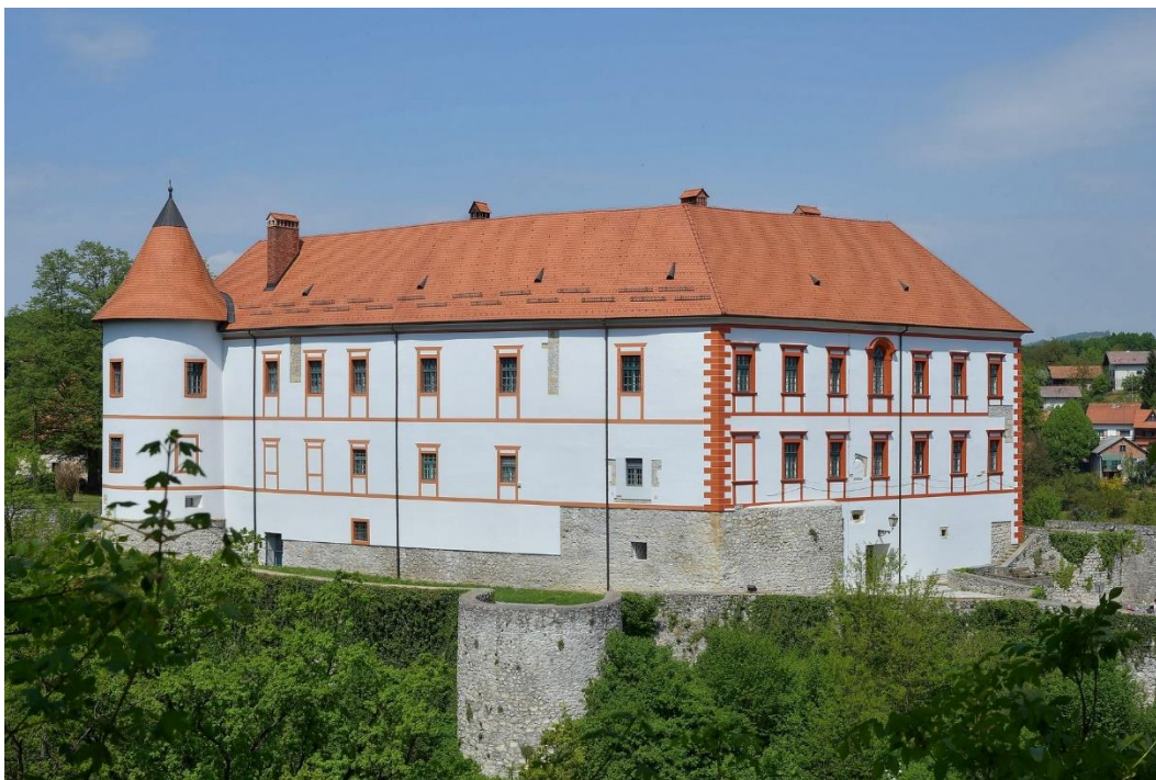
Slika 23: Obnovljeno istočno i južno krilo
