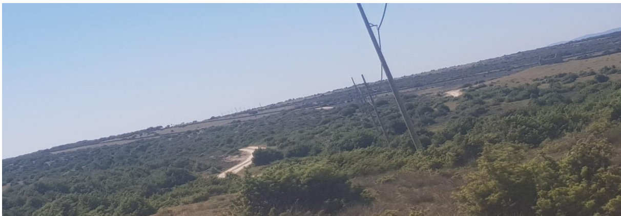
Slika 11: Kablirani dio dalekovoda na Cresu
