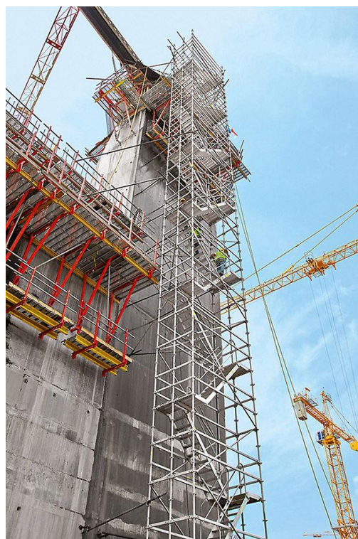
Slika 3. Dogradnja Panamskog kanala – skela [26]
