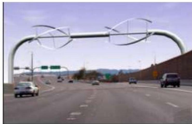
Slika 16 - Horizontalni tip Darrieusove vjetroturbine [4]
