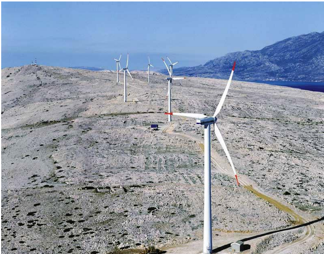
Slika 2 - Vjetroelektrana Ravne 1, Otok Pag [1]
