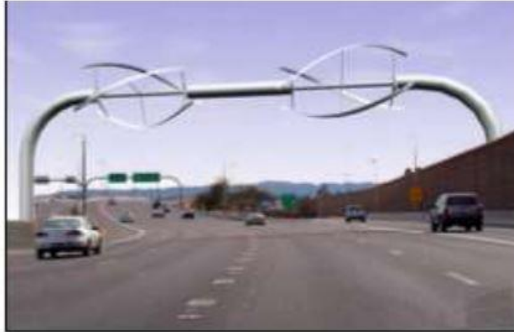
Slika 16 - Horizontalni tip Darrieusove vjetroturbine [4]
