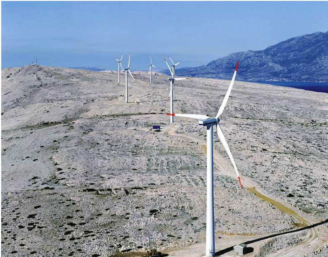
Slika 2 - Vjetroelektrana Ravne 1, Otok Pag [1]
