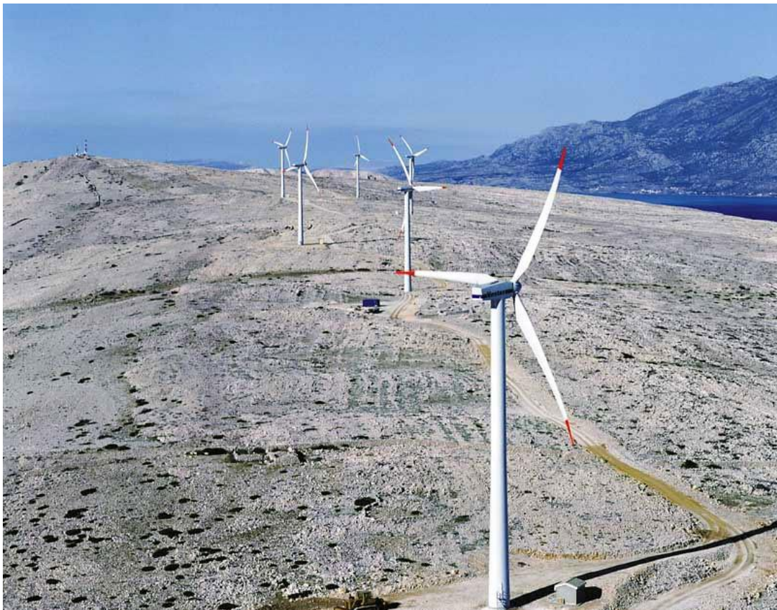
Slika 2 - Vjetroelektrana Ravne 1, Otok Pag [1]
