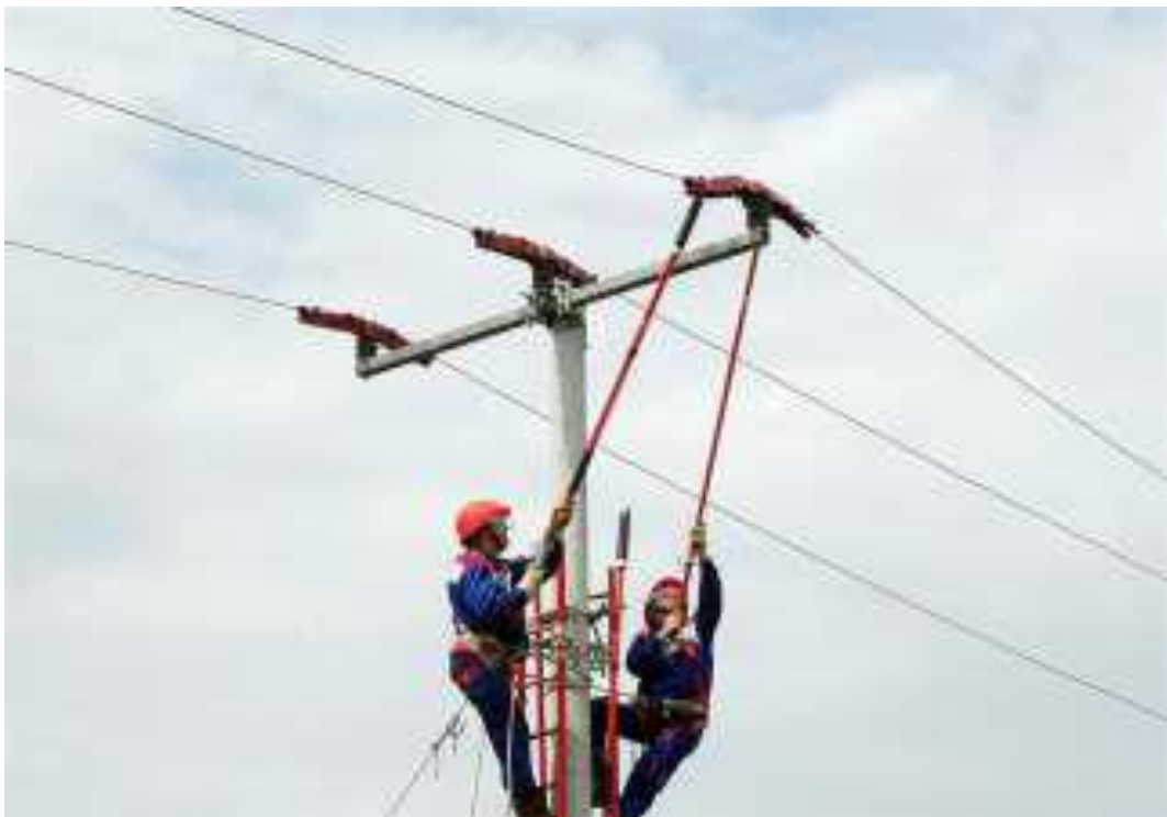
Slika 15. Postavljanje zaštite od ptica na SN vod [17]
