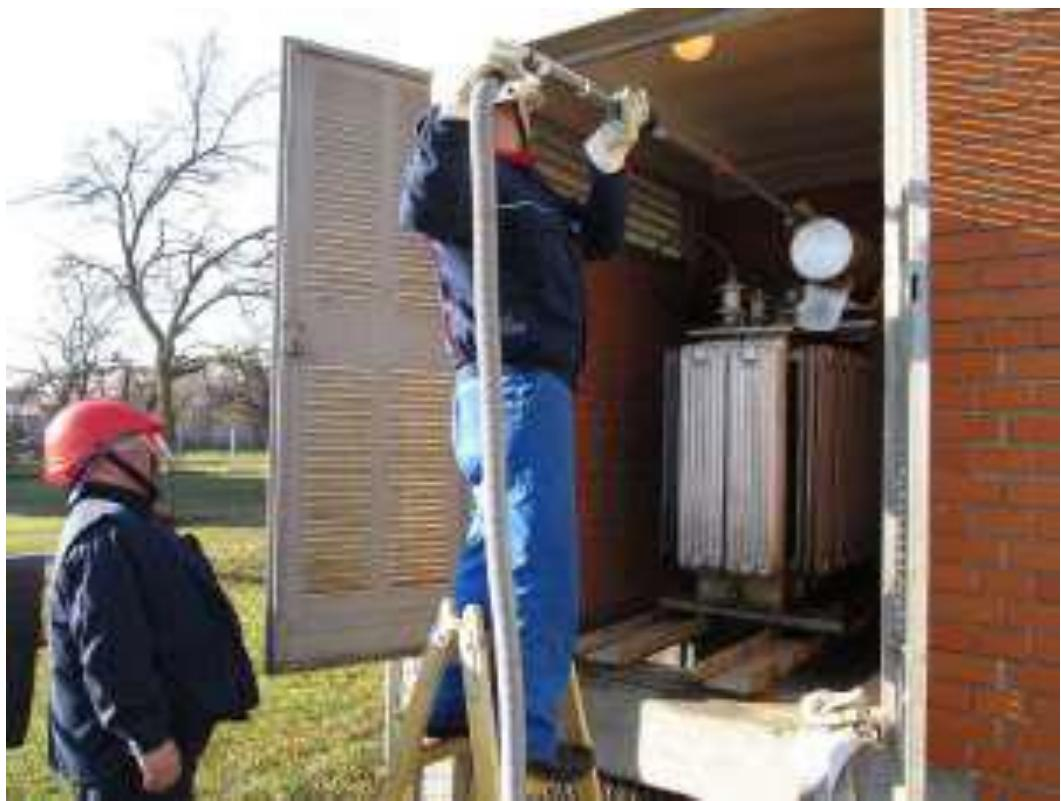
Slika 14. Čišćenje SN/NN kabelske trafostanice pod naponom industrijskim usisivačem [17]
