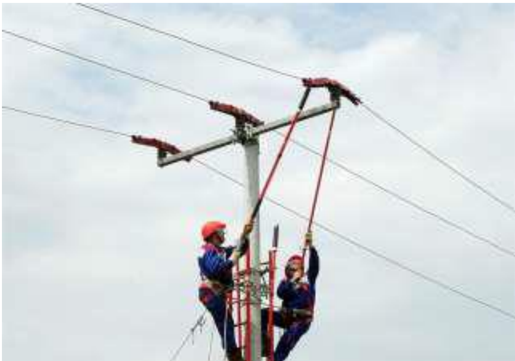
Slika 15. Postavljanje zaštite od ptica na SN vod [17]
