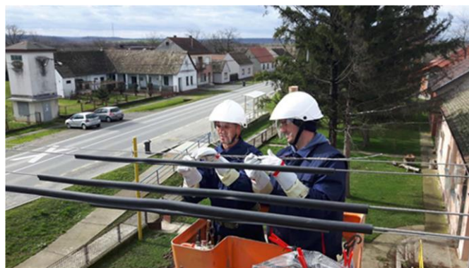
Slika 13. Popravak vodiča na NN mreži pod naponom [17]
