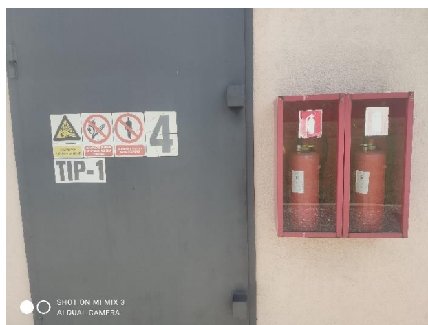
Slika 31. Položaj vatrogasnih aparata za početno gašenje požara [25]
