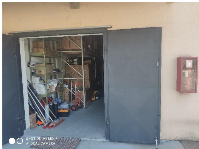
Slika 30. Prozračivanje prostorije skladišta otvaranjem vrata [25]
