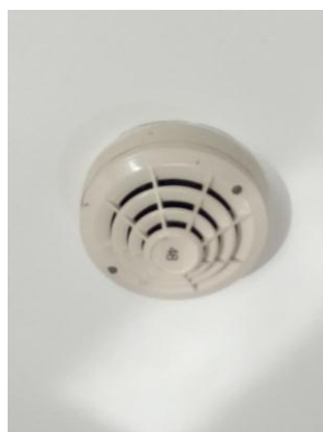
Slika 19: Termodiferencijalni javljač požara
