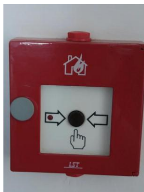
Slika 20: Ručni javljač požara
