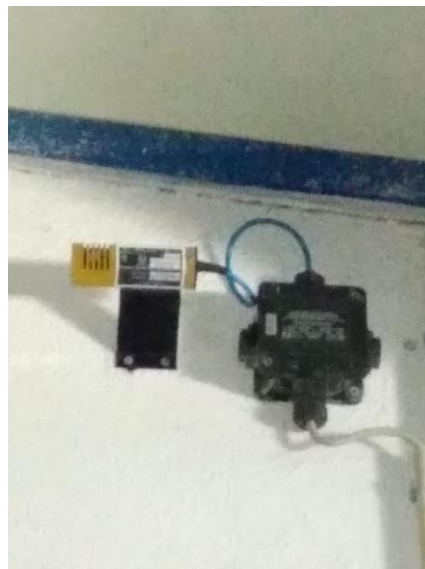
Slika 25: Plinodjavna sonda na zidu Izvor: autorica
