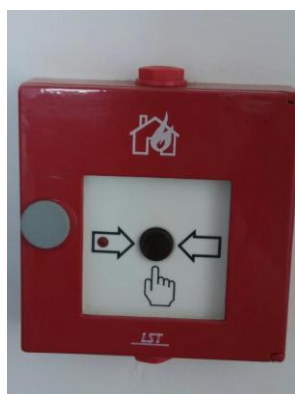
Slika 20: Ručni javljač požara
