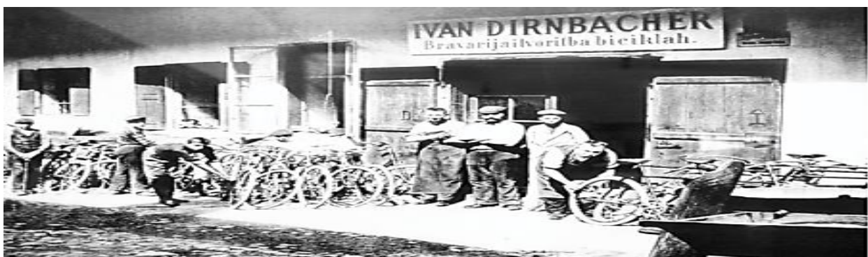
Slika 10. Radionica dvokolica I. Dirnbachera na Preradovićevoj trgu, oko 1890.god [8]
