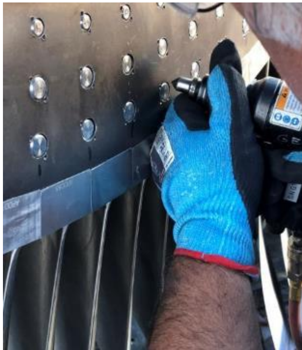
Slika 47. Osiguranje klinova od ispadanja
