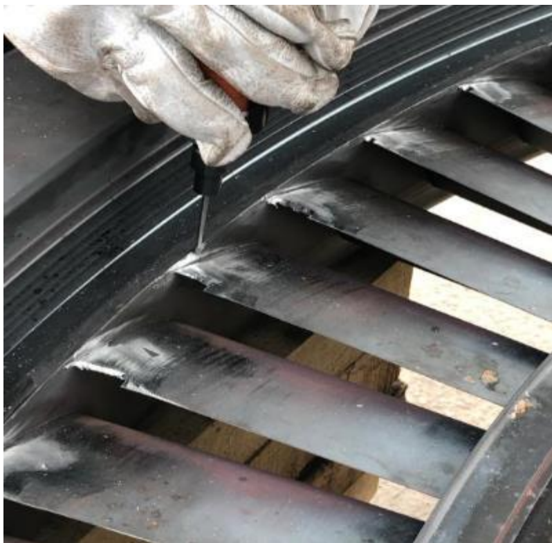
Slika 27. Izrezivanje oštećenih dijelova
