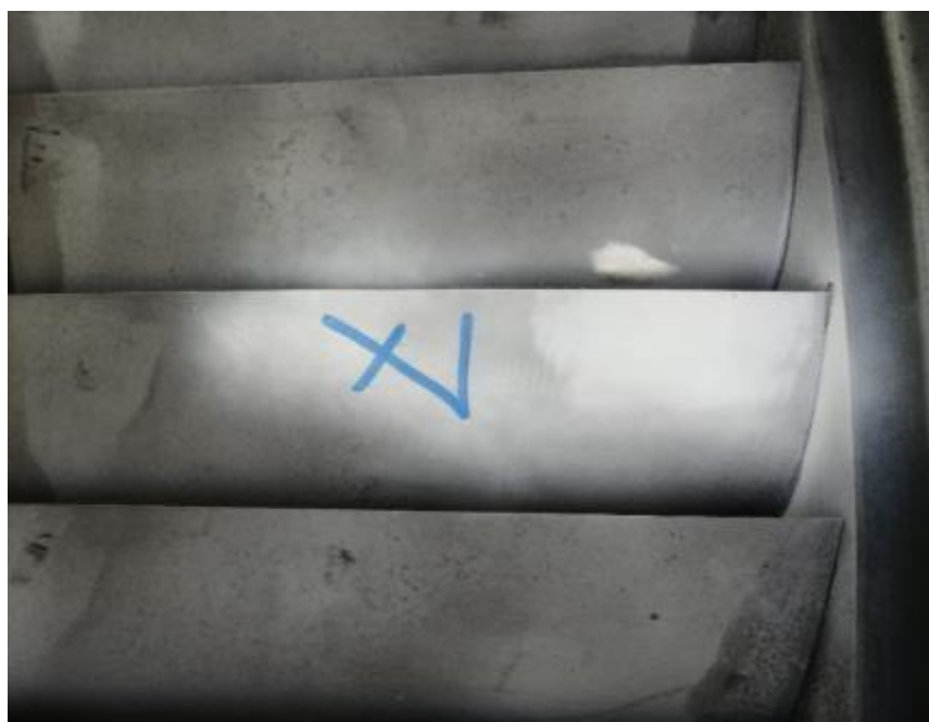
Slika 32. Završna provjera penetrantima nakon popravka
