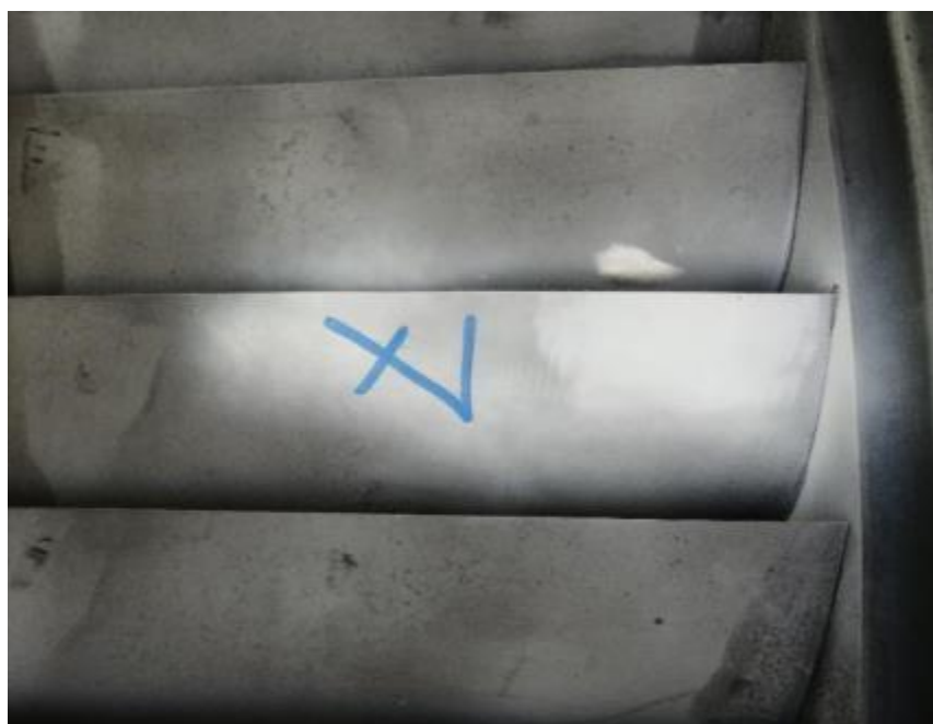
Slika 32. Završna provjera penetrantima nakon popravka
