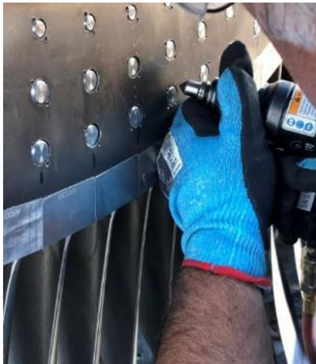
Slika 47. Osiguranje klinova od ispadanja
