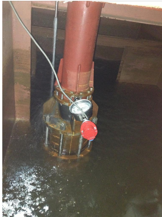
Slika 6. Sonda na mjernom mjestu T1 i rad pumpe kod minimalnog nivoa [9]
