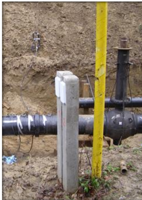
Slika 19. Mjerno mjesto sustava katodne zaštite
