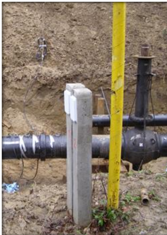
Slika 19. Mjerno mjesto sustava katodne zaštite
